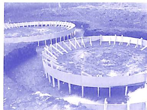
Obras da fundação do Serenarium – Campus de Invexologia, Cognópolis, Foz do Iguaçu (PR).
