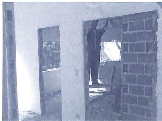
Obras no Residencial Intermissivo
