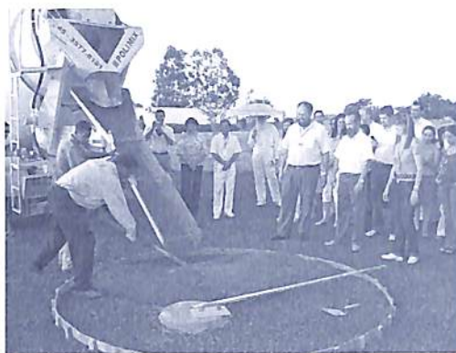
Concretagem no Tertulium
