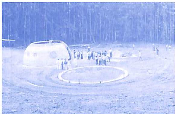
Visita técnica às obras da plenária Aracê
